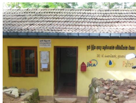
JICAが提供した情報センターの建物（2015年8月撮影）
