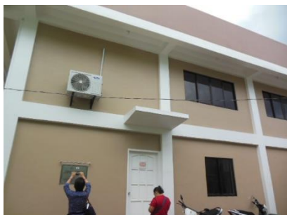
JICA がトロサの女性組織の活動拠点として供与した建物 (2015年7月撮影)
