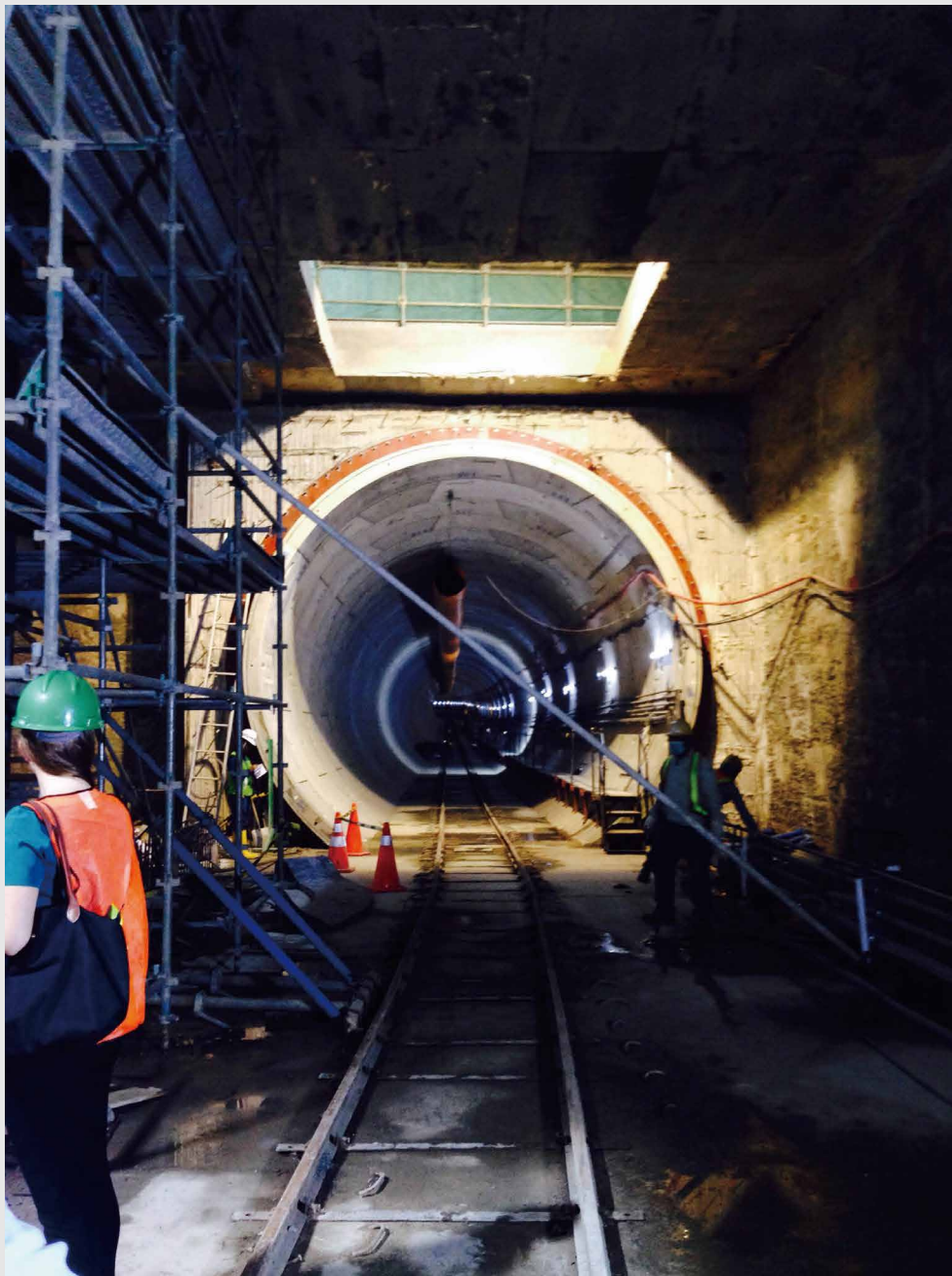
ジャカルタ都市高速鉄道（MRT）事業建設現場
